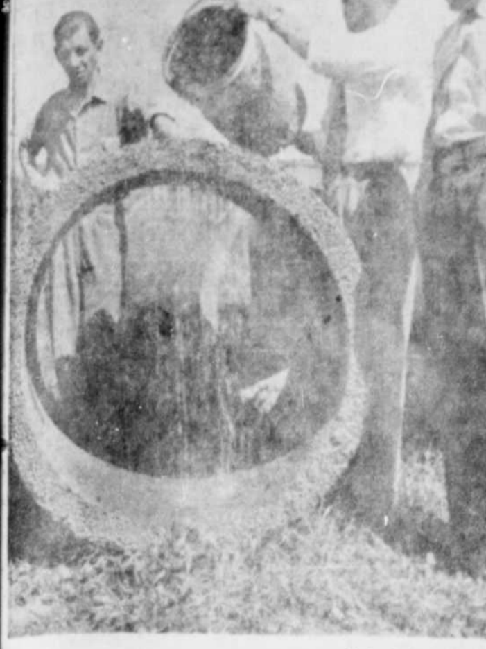
LES TUYAUX "GÉLINITE" fabriqués par Gélinite Inc., à St-Georges de Champlain, sont faits de coke de charbon, et comme le démontre la photo, laisse facilement passer l'eau. Ils servent dans les puits, l'installation de fosses septiques, drainage, etc. De gauche à droite on voit M. Denis Champagne, trésorier, Paul E. Douville, I.P. président et Fernand Fortin, secrétaire. N'apparaît sur la photo M. J.-P. Côté, directeur.
