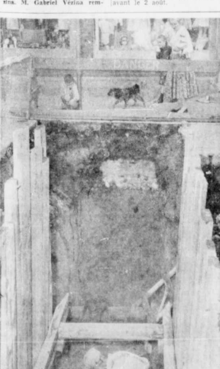
Sur LA 6e AVENUE, à Grand-Mère, des employés municipaux travaillent en ce moment le raccordement des égouts avec les édifices commerciaux.
